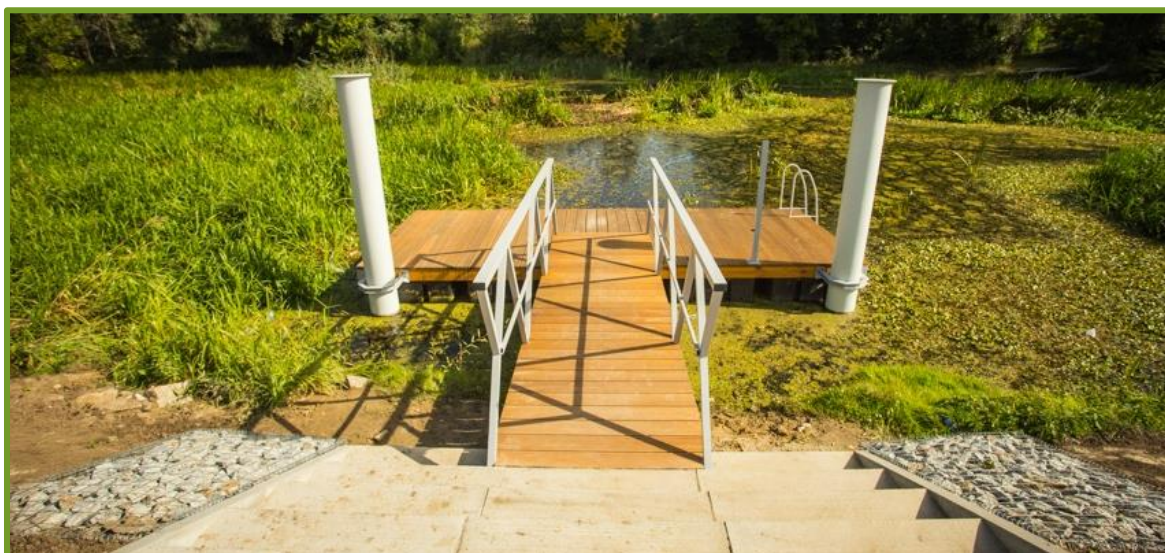
Zdjęcie 6. Nabrzeża rzeki Oławy
