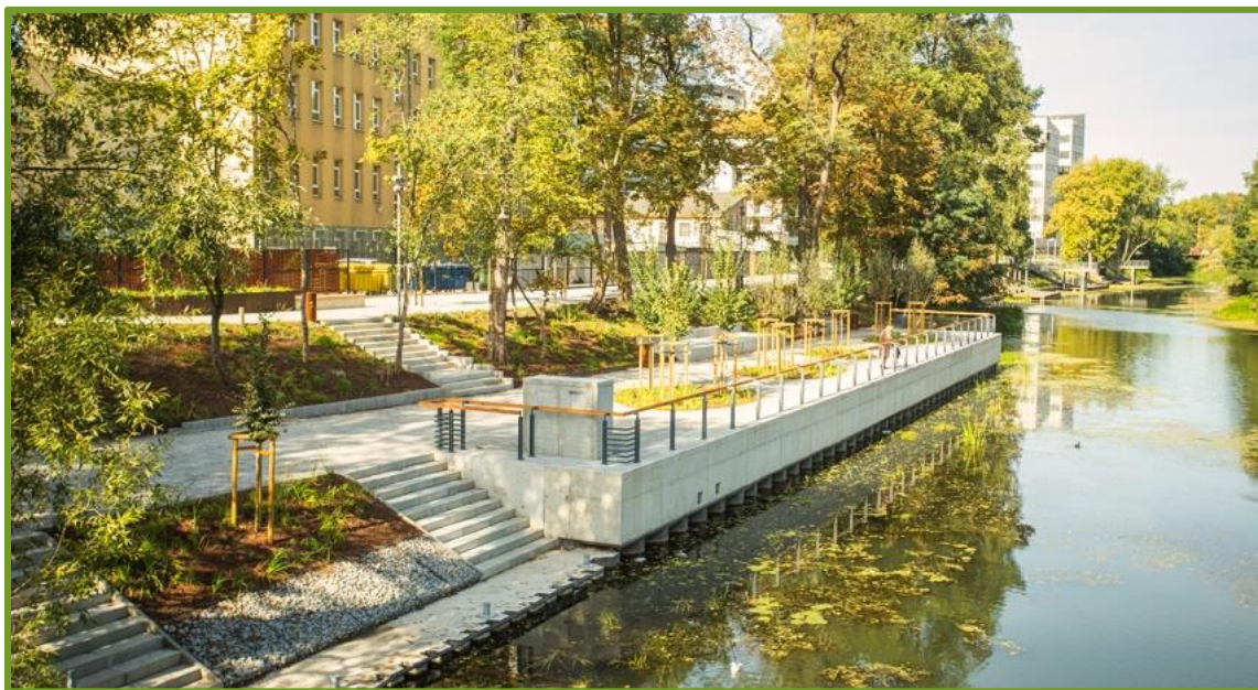
Zdjęcie 5. Nabrzeża rzeki Oławy
