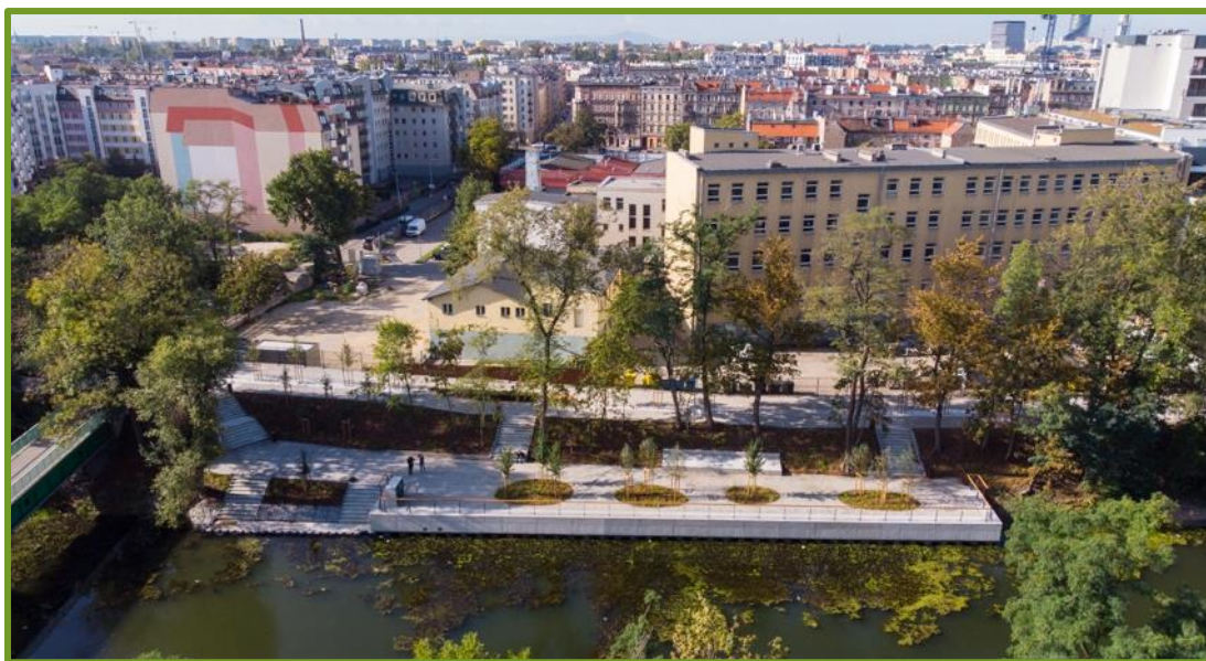
Zdjęcie 4. Nabrzeża rzeki Oławy
