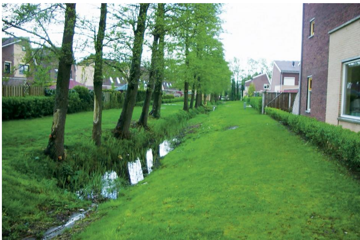
Rys. 2.9. Rów bioretencyjny
