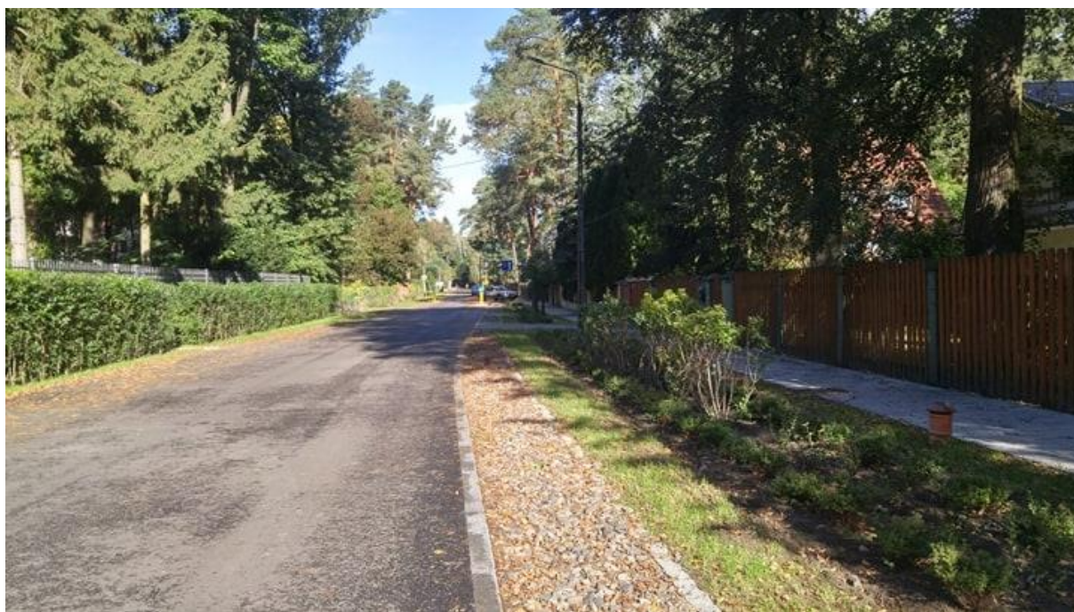
Rys.2.10. Rów infiltracyjny
