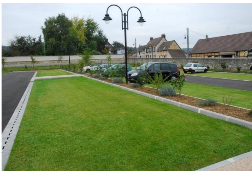
Rys. 2.6. Nawierzchnia przepuszczalna na parkingu
