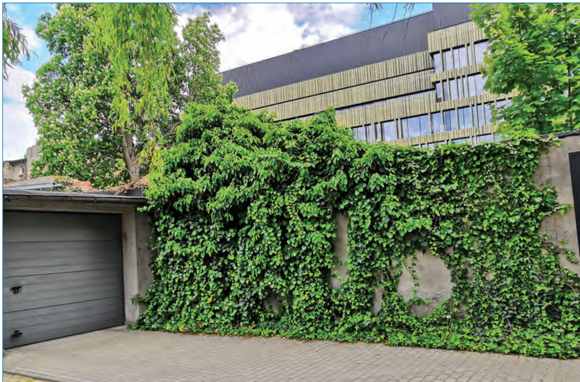
Zdjęcie nr 14. Zielona ściana maskująca zaniedbane mury (fot. D. Wiecha).
