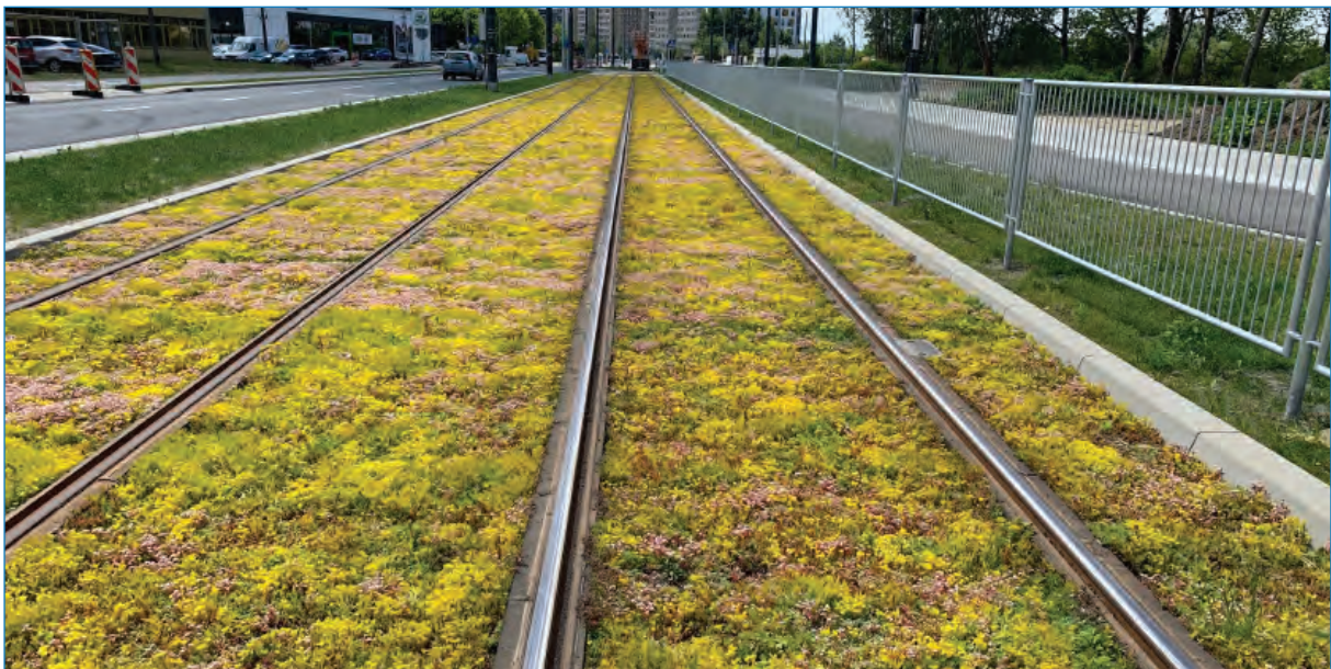
Zdjęcie nr 13. Zastosowanie maty rozchodnikowej na torowisku świadczy o odporności roślin z gatunku Sedum na trudne warunki miejskie
