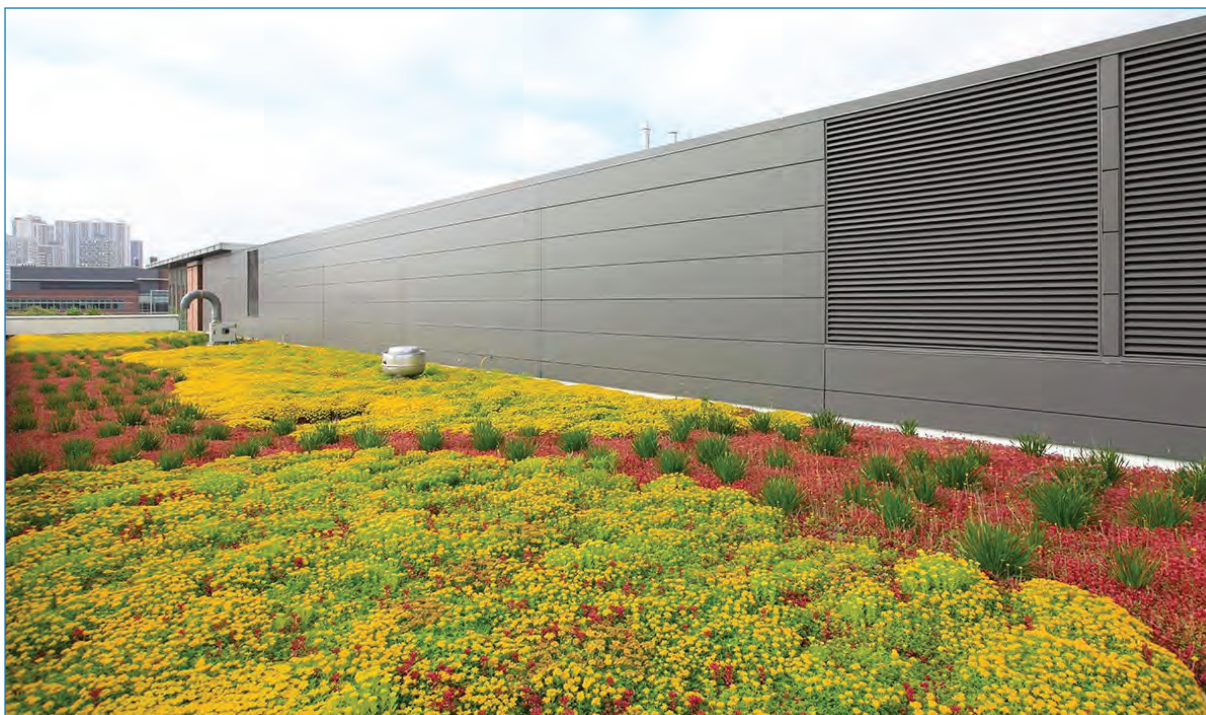
Zdjęcie nr 10. Dach ekstensywny rozchodnikowy
