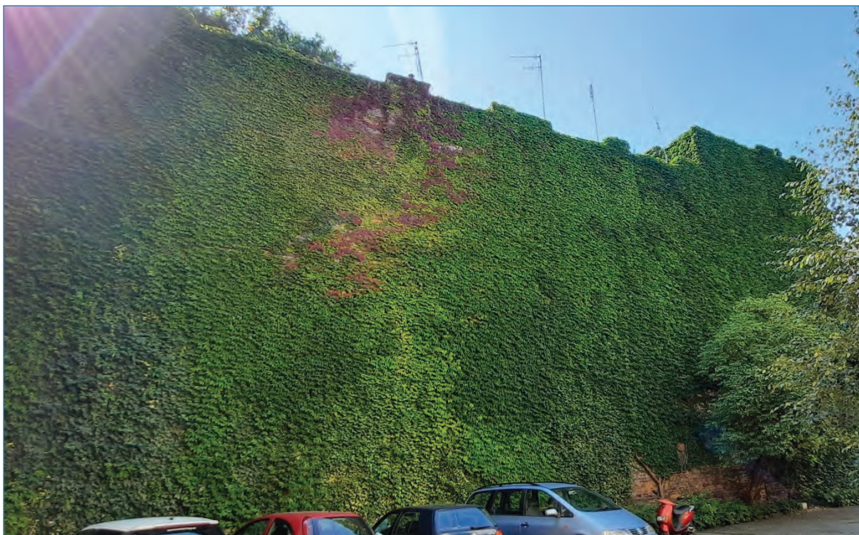
Zdjęcie nr 19. Zielona ściana na dużej powierzchni elewacji
