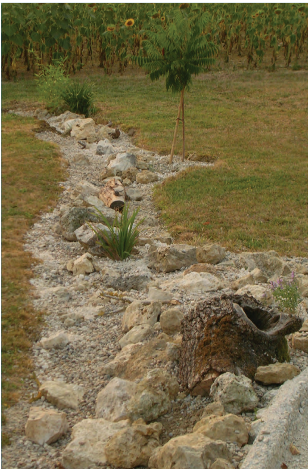
Zdjęcie nr 15. Zagospodarowanie deszczówki w formie suchego strumienia wkomponowanego w naturalne ukształtowanie terenu (fot. A. Woszczyk).
