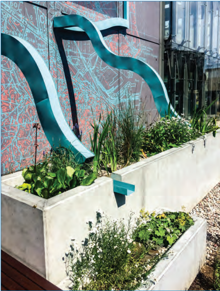
Zdjęcie nr 4. Zagospodarowanie wody z rynny w betonowej donicy
