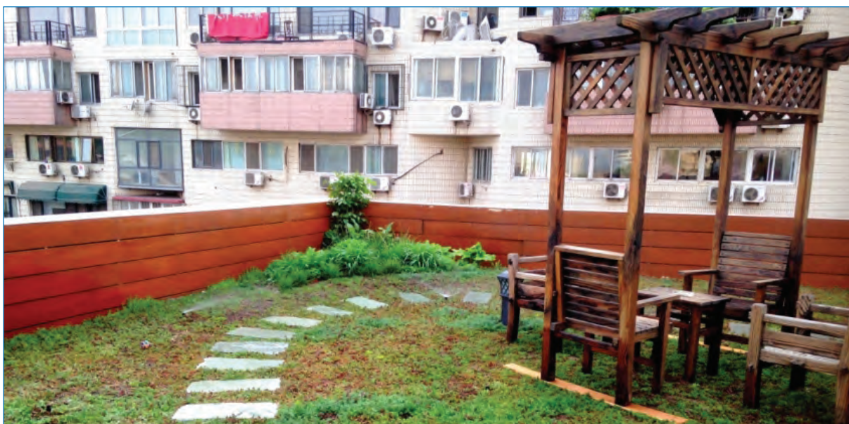
Zdjęcie nr 9. Elementy małej architektury na dachu rozchodnikowym
