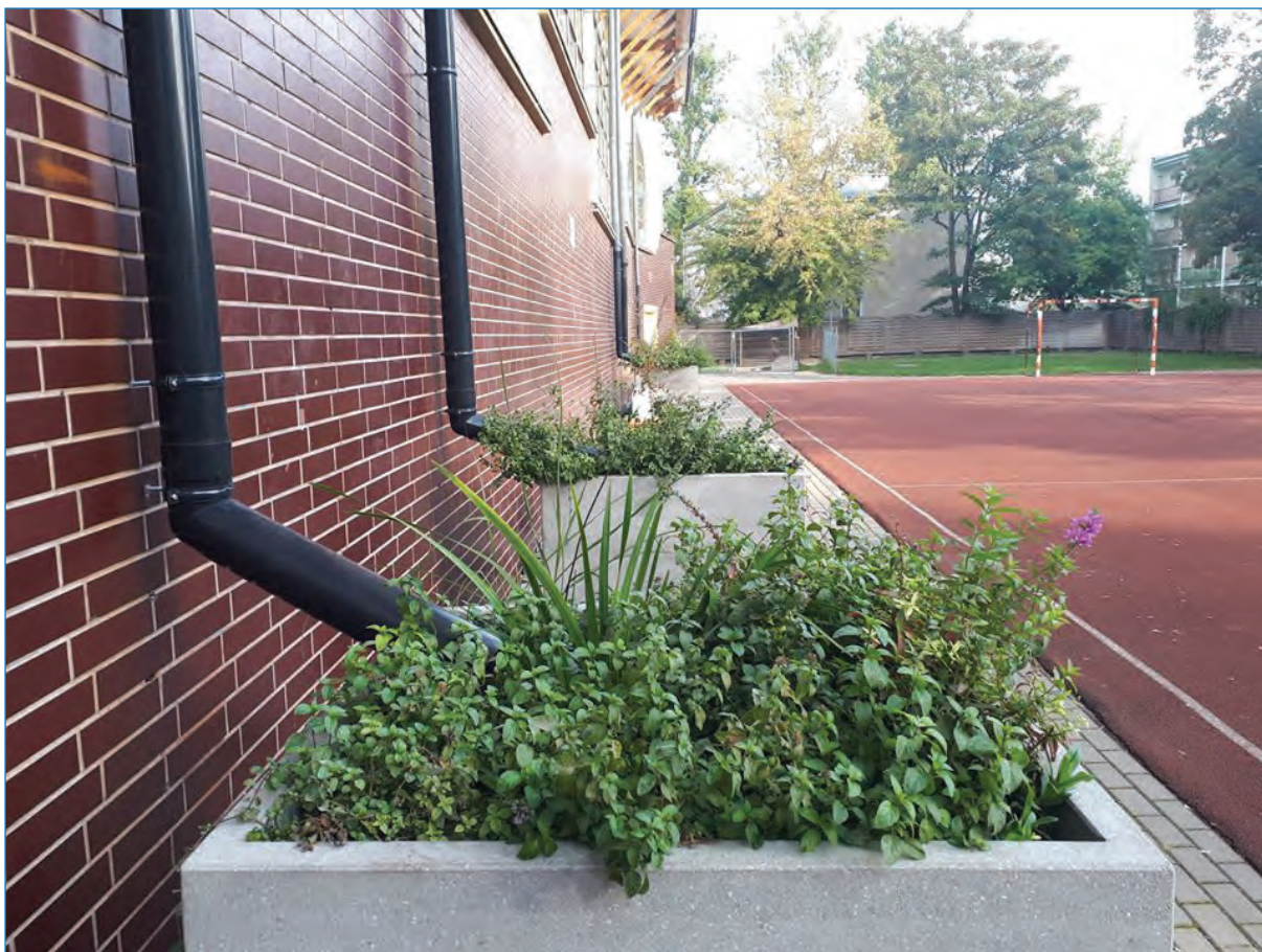
Zdjęcie nr 6. Ogród deszczowy w pojemniku betonowej donicy
