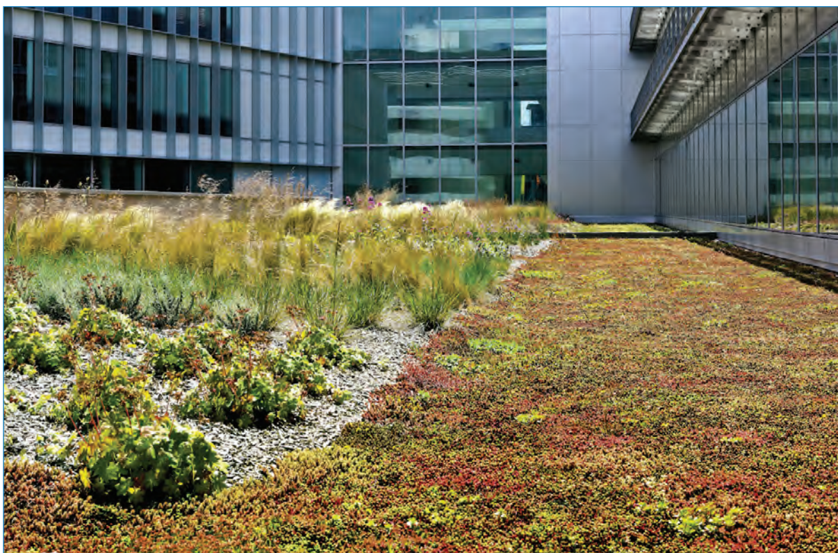
Zdjęcie nr 5. Zielony dach ekstensywny
