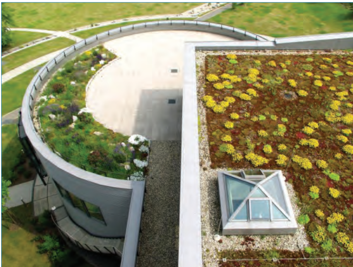
Zdjęcie nr 8. Zielony dach ekstensywny
