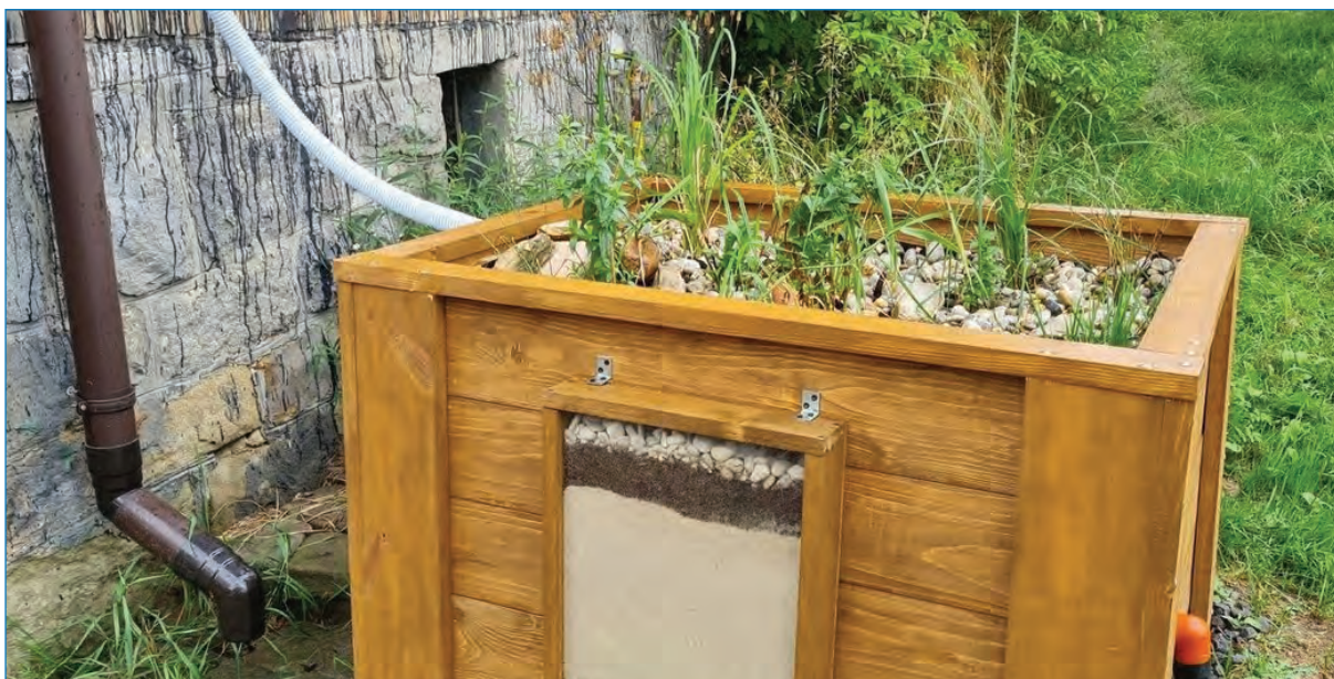
Zdjęcie nr 2. Ogród deszczowy w skrzyni
