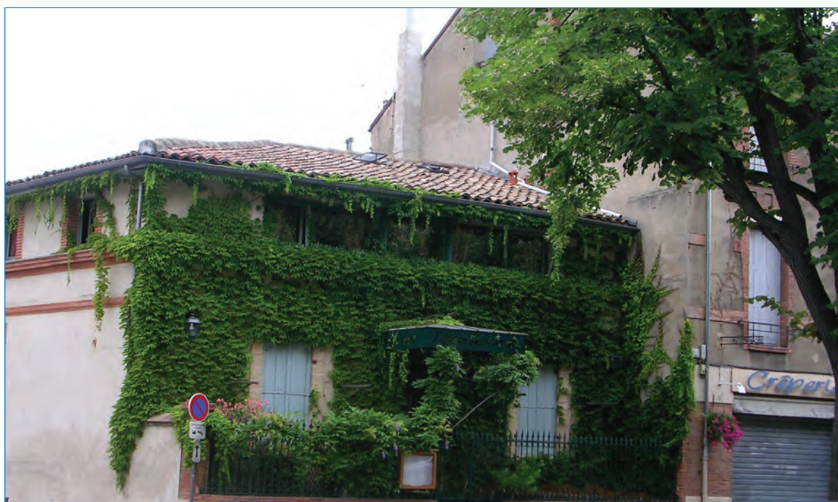
Zdjęcie nr 4. Pręcza na elewacji (fot. A. Woszczyk).
