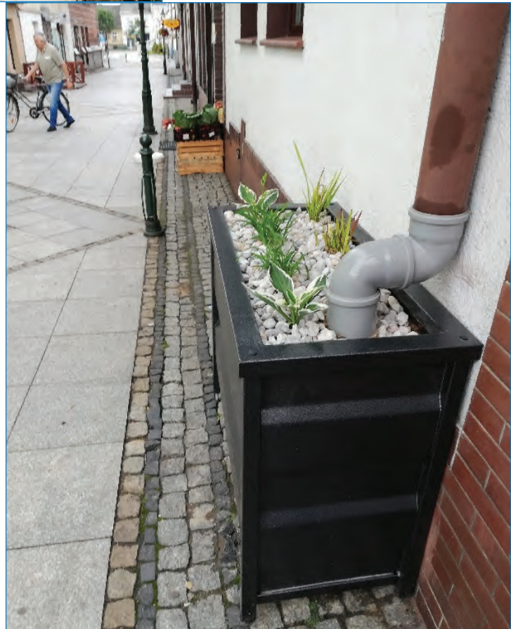
Zdjęcie nr 5. Ogród deszczowy zasilany wodą z rynny
