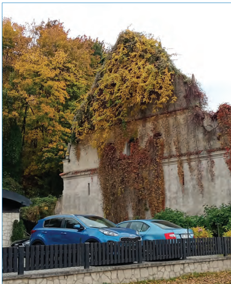
Zdjęcie nr 12. Pnącza na elewacji jesienią (fot. A. Woszczyk).
